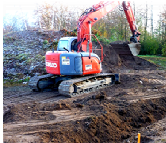
Auftragen der 1. Materialschicht
