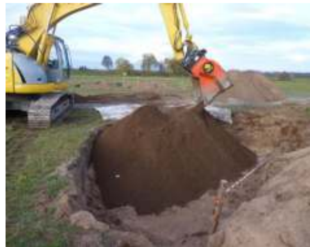
Wiedereinbau der Erde
